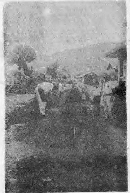
OBRAS DE SANEAMIENTO EN LOS BARRIOS DEL SUR. Especial empeño ha puesto la Municipalidad del Cantón Central de San José, en las obras de saneamiento de los Barrios del Sur de la Capital. En la foto se aprecian los trabajos de alcantarillado que se llevan a cabo en el Barrio Cuaba, en las vecindades del Liceo del Sur.
